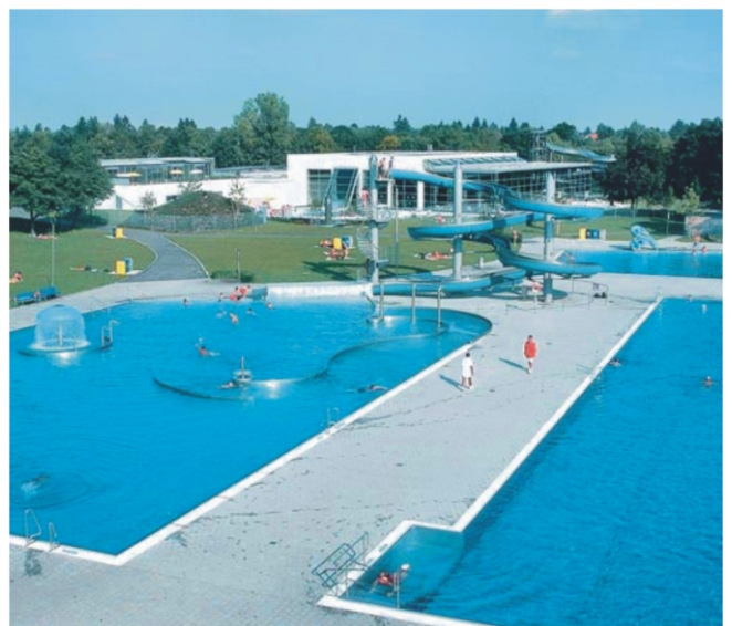
图8 德国慕尼黑的这个游泳池在更换衬里时，采用焊接在一起的316不锈钢板。 供图/Martina Helzel
