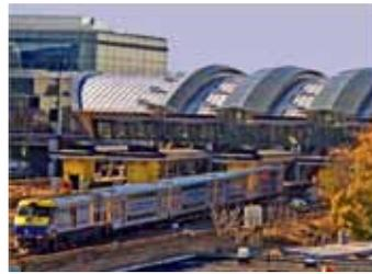
图6 牙买加车站大型低维护316不锈钢屋面
