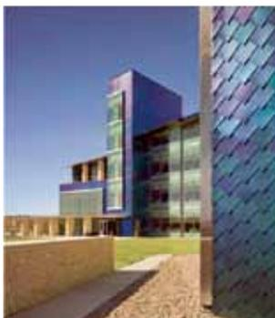
图4 德克萨斯大学大楼的304电化学着色外墙
